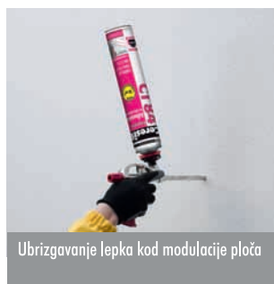
Postavljanje kod sistema "termoizolacija na termoizolaciju"
