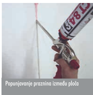
Ubrizgavanje lepka kod modulacije ploča
